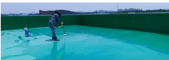
④ 건물옥상 및 미션홀 방수공사
